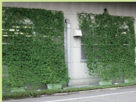
緑のカーテン(工場外壁)
